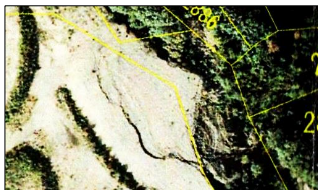
太陽光発電用造成地に入る亀裂の航空写真 造成地のせん断破壊と滑動、液状化、不同圧密沈下の原理などを説明する資料の一つとして用いた。
