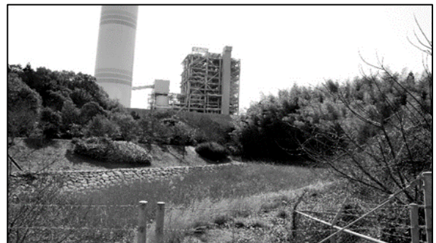
写真2 2020年長島鞍掛から、石炭ガス化炉をみる
