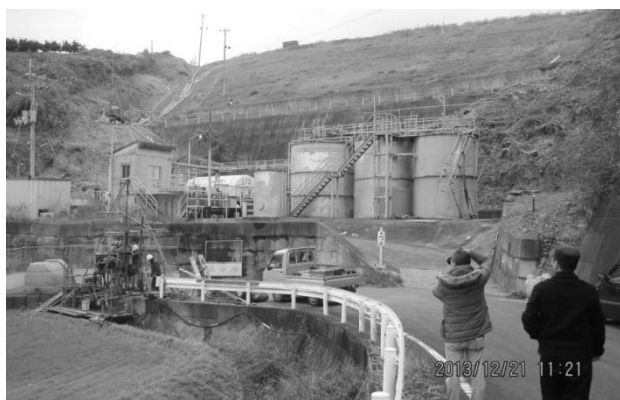
13.12.21 松本撮影 松山市「レッグ」産廃処分場 うず高く積み上げられた産廃。その下に農業用水路配管が埋まっていたが、遮水不完全、そのうえ配管が壊されて有害物質を含む汚染水が流出。
